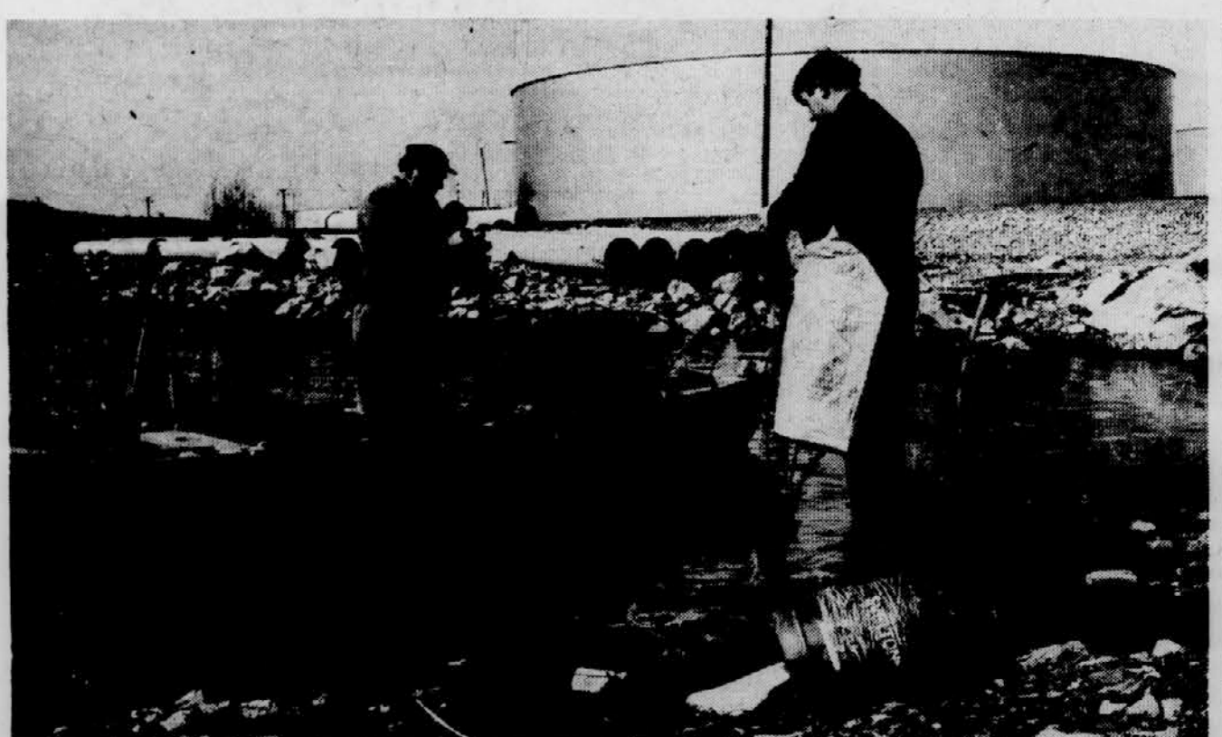
KMALU LE SE PRETEKLOST — Naprave koprške luke se raztezajo od Kopra pa vse pod Sermin na ankaranski strani. Tam, kjer ribiča razmotavata mrežo, bo kmalu kopno. Zadao so cevi, po katerih bodo zasipni material črpali iz morskega dna. Foto: J. Mikuz
