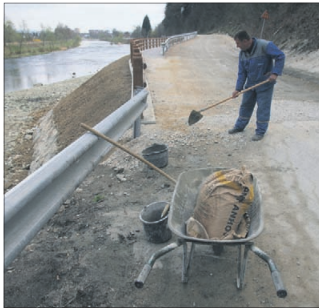
Dela so opravljena, te dni mora obnovljen del vozišča dobiti le še asfaltno prevleko.
