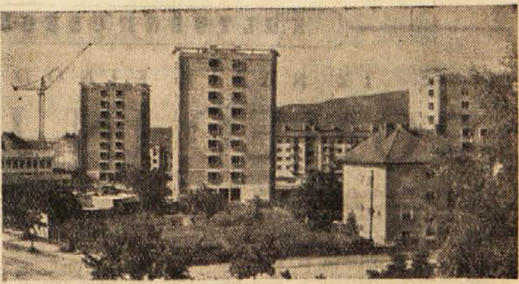
Stolpne stavbe ob Gosposvetški ulici v Mariboru med gradnjo
