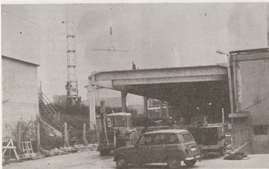
Gradnja prizidka ob grobem razrezu je po enem mesecu dobila skoraj dokončno obliko. Gradbenim delavcem je šlo do sredine decembra, ko je nastal ta posnetek, vreme zelo na roko!
