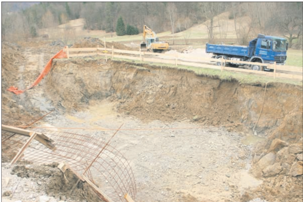
Do oktobra bo tu, kjer zaenkrat zeva velika gradbena jama, zrasla čistilna naprava Frankolovo.
