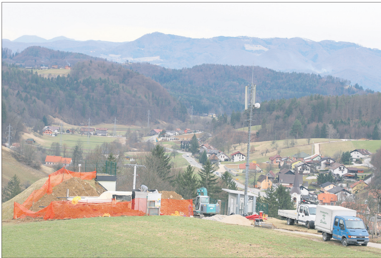
Pri zbiralniku vodnega vira Šibanc na Gojki so se začela gradbena dela, v naslednjih dveh mesecih naj bi bila nameščena tudi filtrirna oprema.
