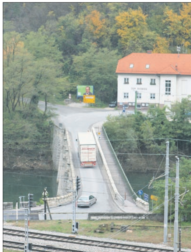
Ta most čez Savinjo bo po gradnji novega mostu namenjen le še za pešce in kolesarje.
