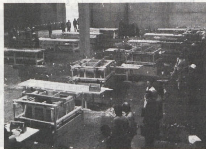
PRIZORIŠČE DELA TESARJEV.
