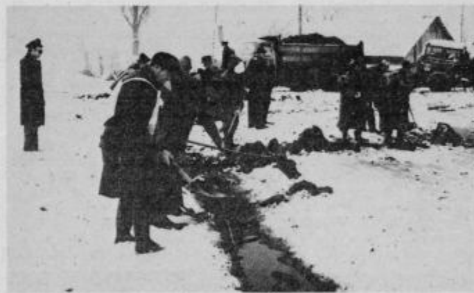
Delavci komunalnega podjetja odstranjujejo strjeni mazut.
