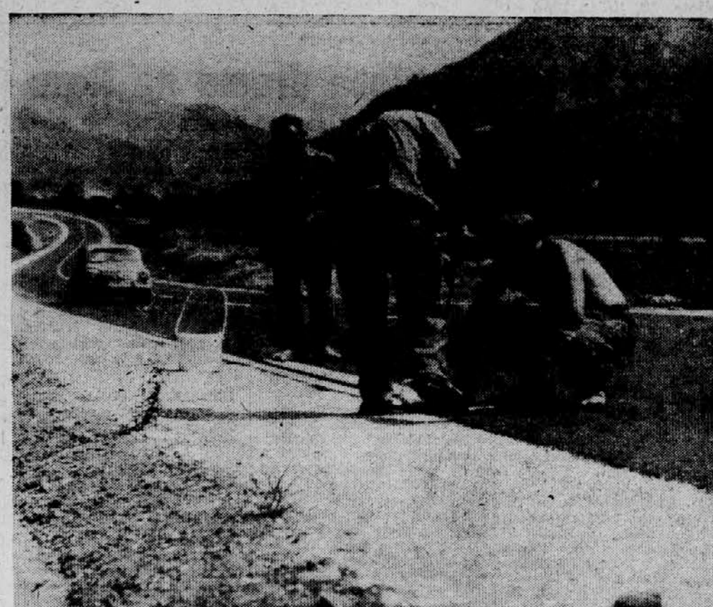
NOVA TRZIŠKA CESTA — Pred dnevi so neuradno odprli novozgrajeni odsek ljubljanske ceste od Naklega pa do Trčica. Cesta je moderna, široka sedem in pol metra in je prva tretjina betonska, ostala pa je asfaltirana. Tik pred Trčicem grade še bencinsko črpalko, na cesti pa se odvijajo le še obrobna, zaključna dela. (Foto: Tone Fornetzi)
