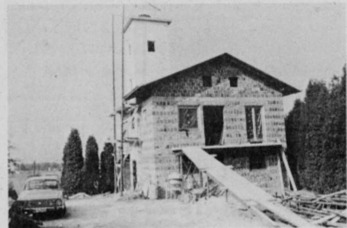
Ob starem stolpu je zrasel novi gasilski dom.
