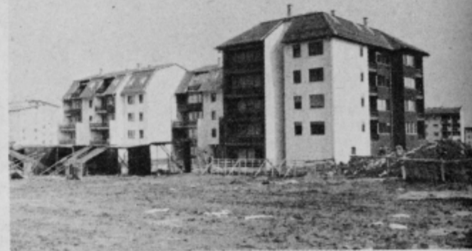
Zaporedje novih stanovanjskih blokov v naselju Zg. Bistrica je največje gradbišče družbenih stanovanj v občini
