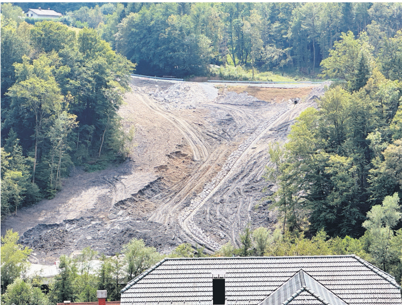
Občina Radeče naj bi do konca leta sanirala plaz Žebnik, ki se je sprožil leta 1984 in je ogrožal več stanovanjskih in gospodarskih stavb. (Foto: Občina Radeče)
