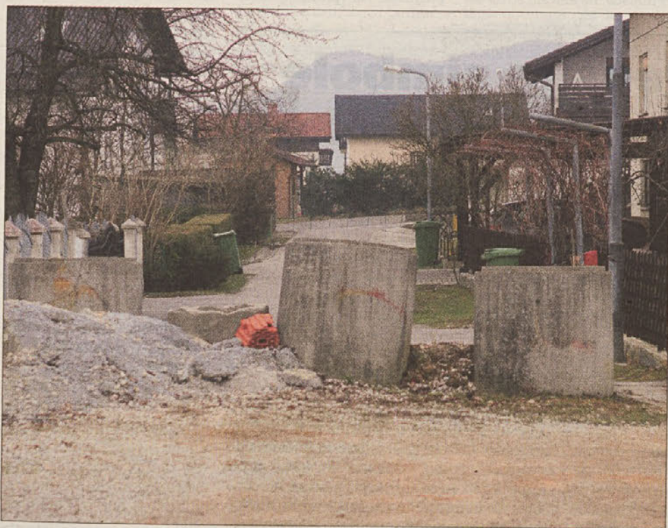
Betonski stebri kot meja med zgornjim in spodnjim delom ene in iste ceste
