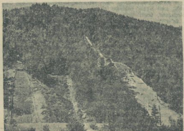
Velika skakalnica v gradnji
