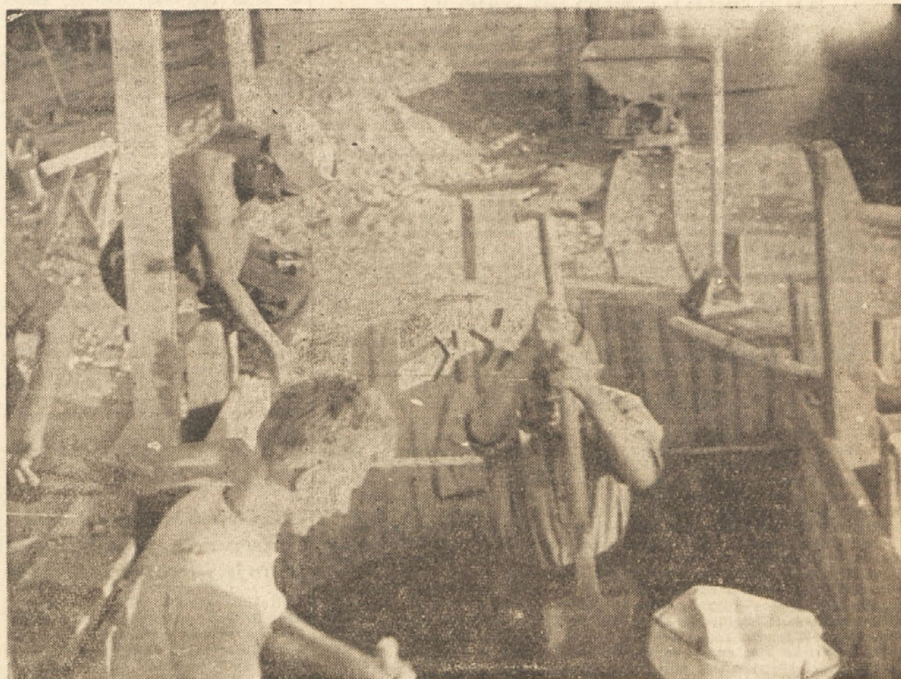
Vojkovi brigadirji pri gradnji temeljev mostu v Bjeli
