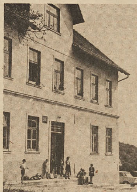
Osnovna šola na Vinskem vrhu na zunaj ni videti poškodovana, toda učenci v njej ne bodo več varni. (Foto: T. Urbas)
