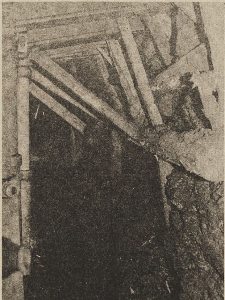
Delo na širokem čelu, ki je podprto s hidravličnim Salzgitter podporjem
