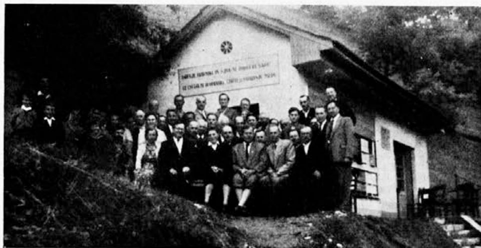
Čebelarji celjske družine pred novo zgrajenim čebelnjakom
