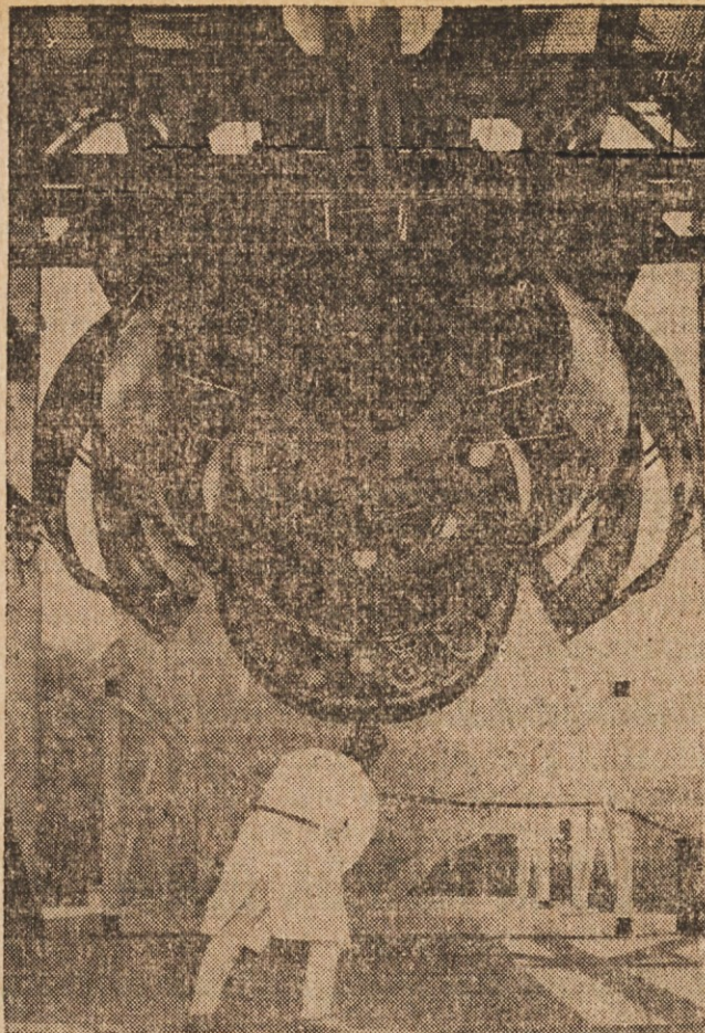
PRI PREGLEDU JETA — Tehnik si ogleduje turbofan letalski motor v delavnicih, tovarne General Electric v Peebles, Ohio.
