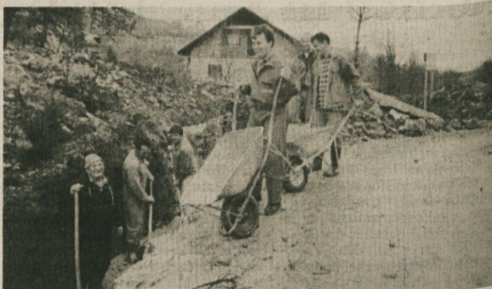
CEVI SO ZASIPANE - Krajanje Pahe so jeseni vsako vedro popoldne pa tudi sobote in nedelje izkoristili za delo pri novem vodovodu in še pred prvim snegom med Črešnjicami, Herinjo vasio in Paho zasipali blizu 10 km jarka, v katerega jim je poleg vodovodnih cevi uspelo položiti tudi telefonski kabel. Kljub temu ta del krajevne skupnosti Otočec še ne bo tako kmalu prišel do tekoče pitne vode, saj bo do slavnostne otvoritve treba zgraditi še dva vodohrana. (Foto: I. V.)
