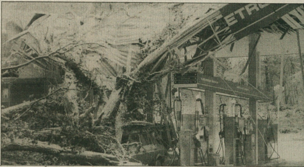
HRAST PORUŠIL PETROLOVO ČRPALKO - Petrolov bencinski servis ob Ljubljanski cesti v Bršljinu so na novo zgradili v letošnjem juniju. V torek zjutraj ob pol osmih se je pod težo snega zrušil nanj mogočen stoletni hrast in pokriti del črpalnice spremenil v ruševine. "Zagrmelo je, počilo in se je pokadilo. Prve trenutke niti nismo vedeli, kaj se dogaja", je pod vtisom nesreče povedal izmenovodja Ivan Sašek, ki se ima zahvaliti, le srečnemu naključju, da je bila vsa jutranja ekipa tisti trenutek na varnem v prostorih trgovine. Tam je bil tudi Dragan Matič, ki se je prav tisti čas s svojo stoenko pripeljal po gorivo. Sreča je hotela, da se vrata za gorivo niso hotela odmrzniti, zato je skupaj s črpalkarjem odšel v trgovino, da bi si kupil odmrzevalno sredstvo. Če bi ostal v avtu, bi bil verjetno že med pokojnimi, saj je prvi del stoenke pod mogočnim deblom hrasta popolnoma sploščil. (Foto: J. Pavlin)
