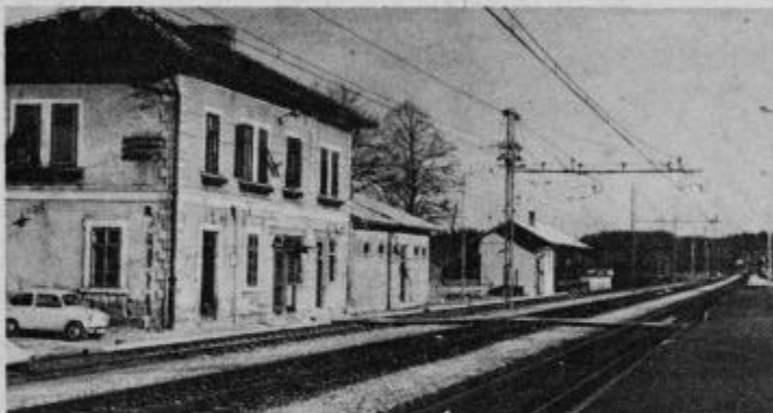
Elektrifikacija proge in preurejanje zgradbe postaje Slovenska Bistrica prehaja v zaključno fazo
