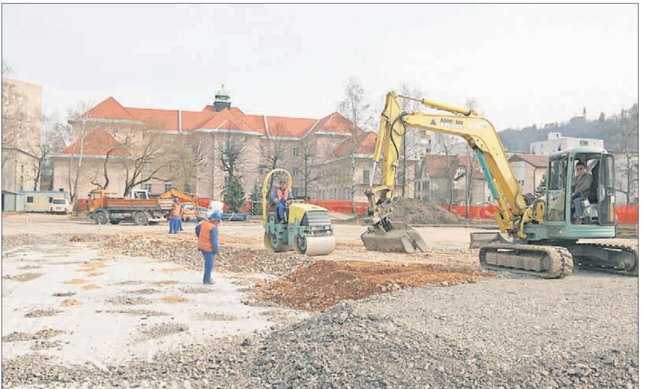
Pri I. celjski gimnaziji so zabrnili delovni stroji. Najprej bodo prestavili in posodobili zunanje športne površine, nato naj bi na vrsto prišla gradnja težko pričakovane telovadnice.
