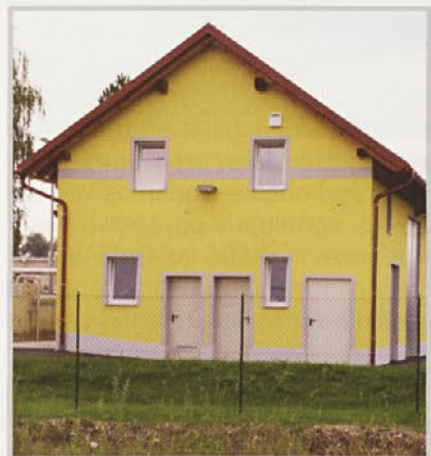
Čistilna naprava Formin
