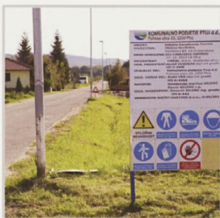
Gradbišče kanalizacije na Forminu...
