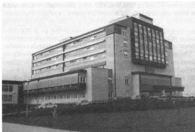
Sl. 4. Stavba kirurškega bloka s severovzhoda.
