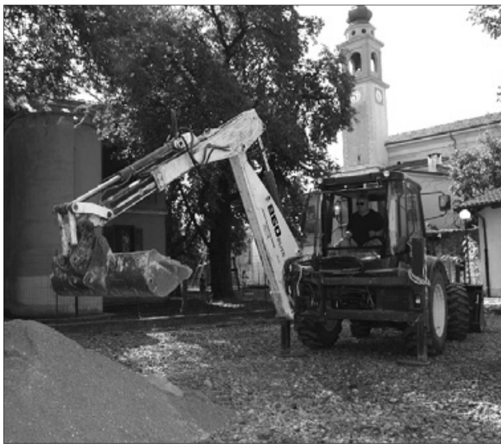
Na dvorišču štandreške šole so dela v polnem teku
