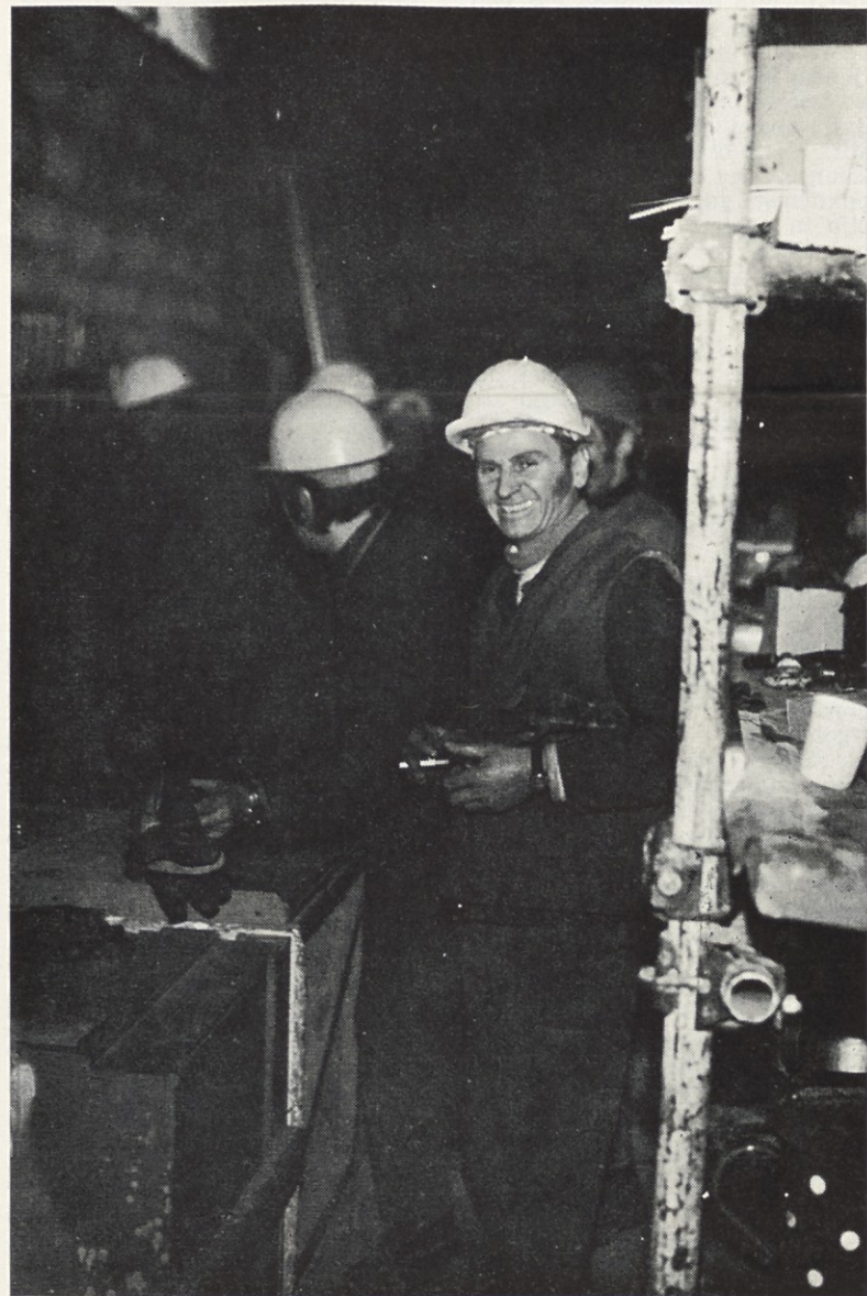
»Zadovoljni smo, da montaža teče v redu,« pravi Miloš Štefanovič
