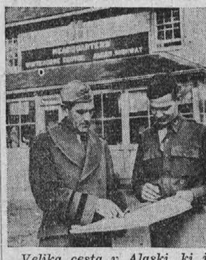
Velika cesta v Alaski, ki jo gradi ameriško vojaštvo, bo izgrajena že 1. decembra, to je, 10 mesecev pred določenim časom. Na sliki sta general V. Hoge, načelnik konstrukcije, in major E. J. Stumm.
