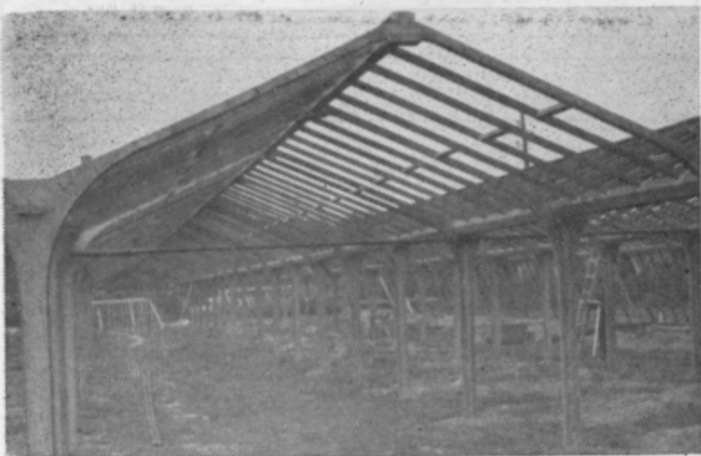
Železobetonsko ogrodje vrtinarije s toplovodnim ogrevanjem v Velenju
