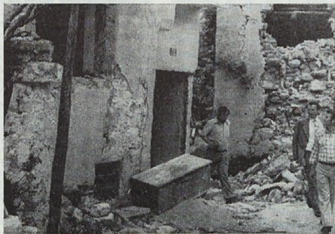
V vasi Podbela je porušeno večina hiš. Tak je pogled na eno izmed 40-tih, ki jih bo potrebno porušiti
