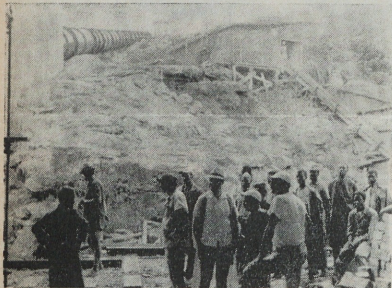
Na gradbišču HE v Gvineji
