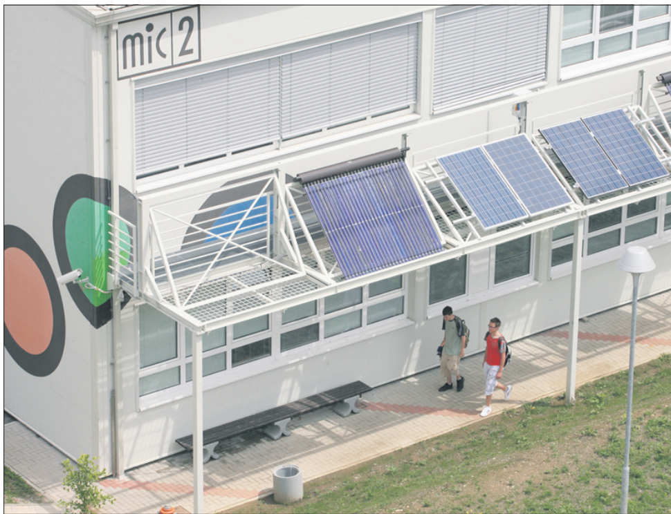
Na energetskem poligonu bo moč videti različne načine, kako uporabljati obnovljive vire energije. Energetski poligon je z uporabo teh virov samozadosten.
