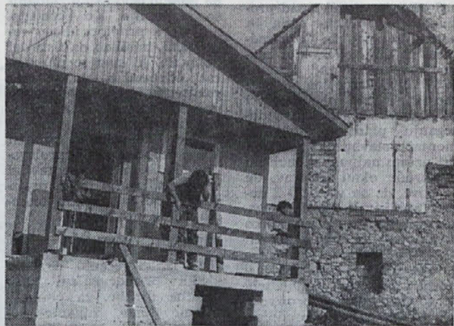
Monterji pri delu
