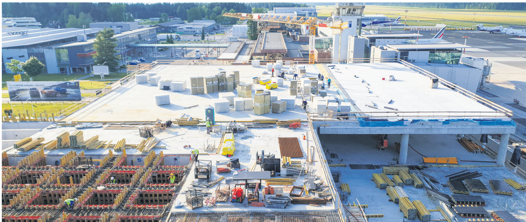
Med največjimi lanskimi in letošnjimi gradbenimi projekti podjetja Gic Gradnje je nov potniški terminal na brniškem letališču. (Foto: Gic Gradnje)
