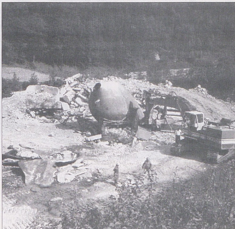
Na zemljišču bivše tovarne celuloze Obir bo občina Železna Kapla zgradila napravo za delitev odpadkov. Naprava bo stala približno milijon šilingov.
