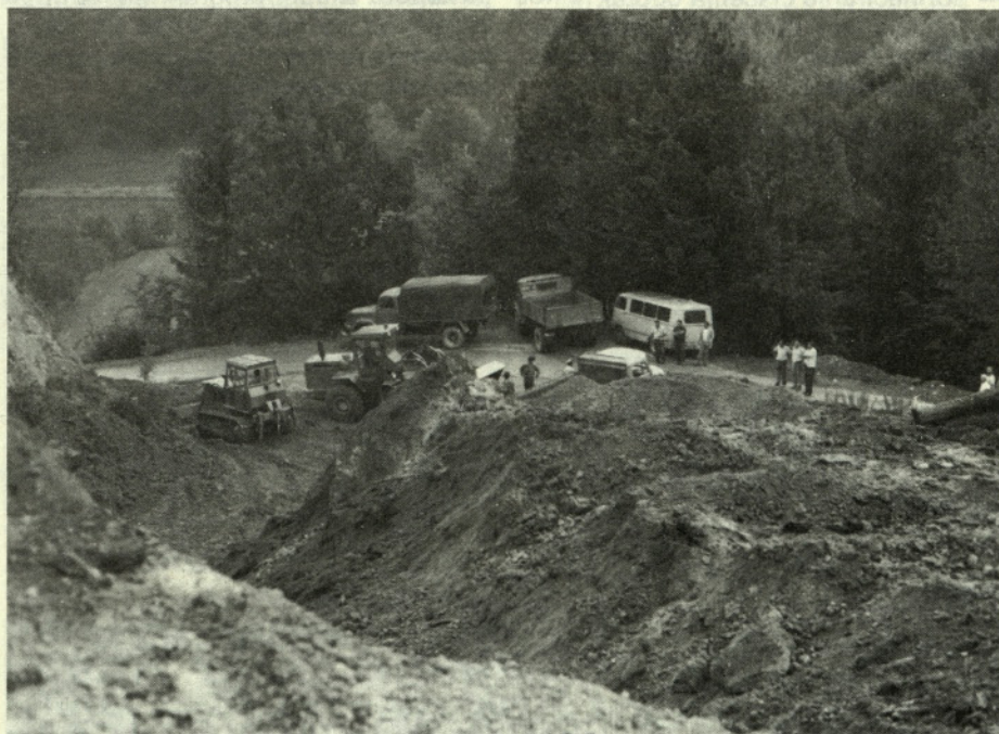
Rekonstrukcija ceste Dobovec - Log
