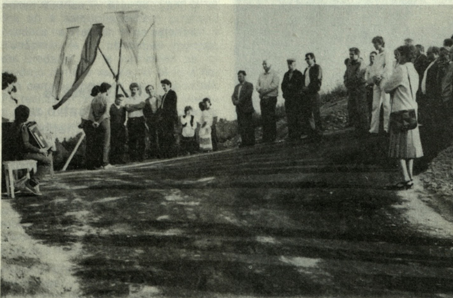
Asfaltna povezava KS Lesično - Buče - Kozje
