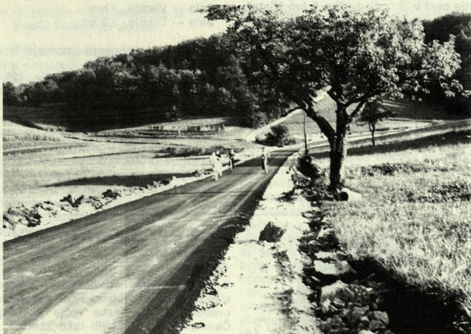
Z novim samoprispevkom bo dokončno zgrajena cesta Šmarje - Ločnec - Vinski vrh
