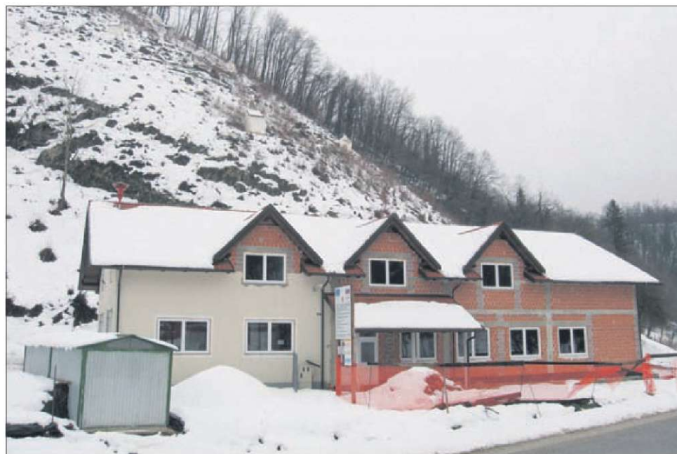
Z gradbišča novega doma krajanov v Podstredi, ob glavni cesti proti Kozjem. Stara dvorana je bila dotrajana, zato potrebujejo novo.
