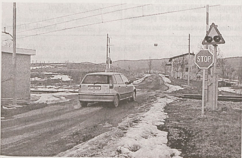
Železniški prehod z novimi polzapornicami, ki so bile postavljene junija 1999. (Foto: M. Urh)
