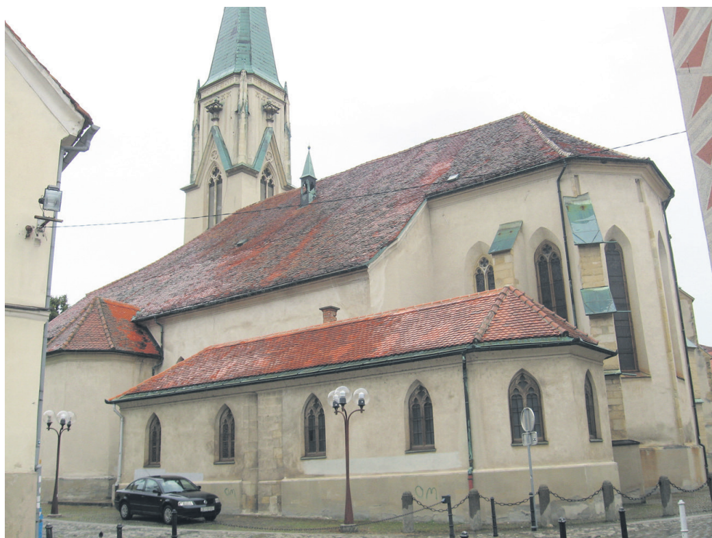
Celjska stolnica, ki je posvečena sv. Danijelu. Njena streha je bila nazadnje obnovljena pred približno pol stoletja.
