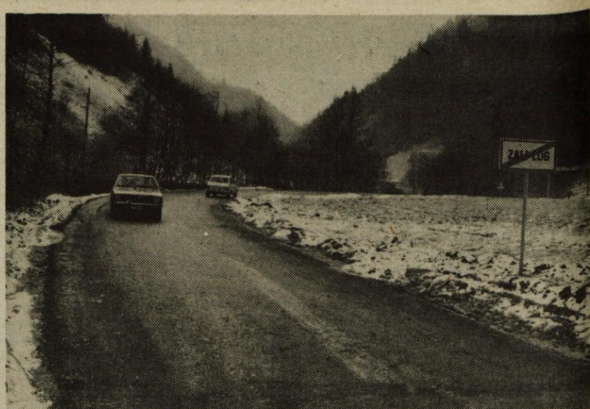
Zali log, Področje v Selški dolini - Delavci Cestnega podjetja iz Kranja so pred dnevi položili asfalt na cesti od Zalega loga do Podrošta. Asfaltirani odsek je dolg 3,5 kilometra. S tem je odpravljeno še eno ozko grlo na cesti, ki povezuje Gorenjsko s Primorsko ter Selško dolino s Sorico in Bohinjem. Že dlje časa je v načrtu tudi asfaltiranje ceste iz Podrošta proti Petrovem brdu in nadaljnje urejanje ceste proti Sorici. Denar za ureditev in asfaltiranje cestnega odseka sta prispevala republiška skupnost za ceste in loška občina. (-jg) - Foto: F. Perdan
