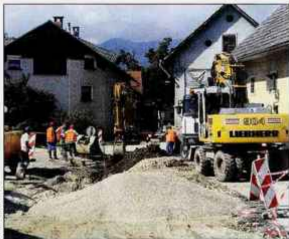
Rekonstrukcija regionalne ceste na Zgornjem Brniku
