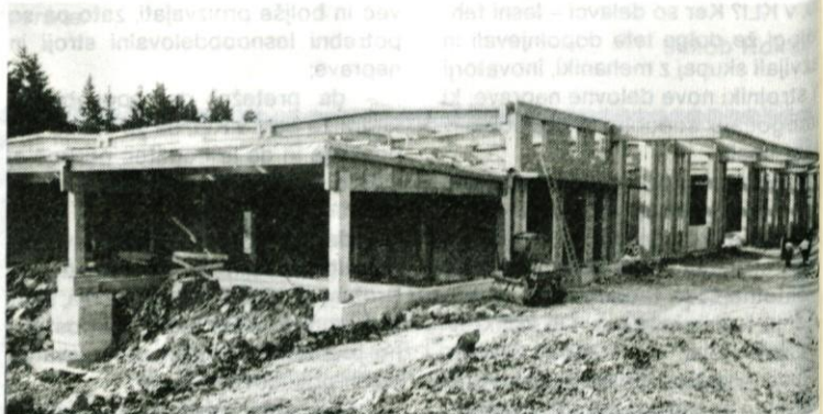
Tovarna lesnoobdelovalnih strojev v času gradnje
