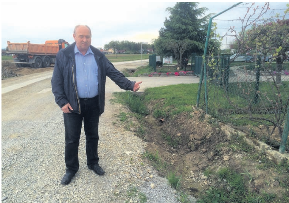
Gorazd Železnik, predsednik Krajevne skupnosti Ljubecna, na območju gradnje kanalizacije v spodnjem Začretu.
