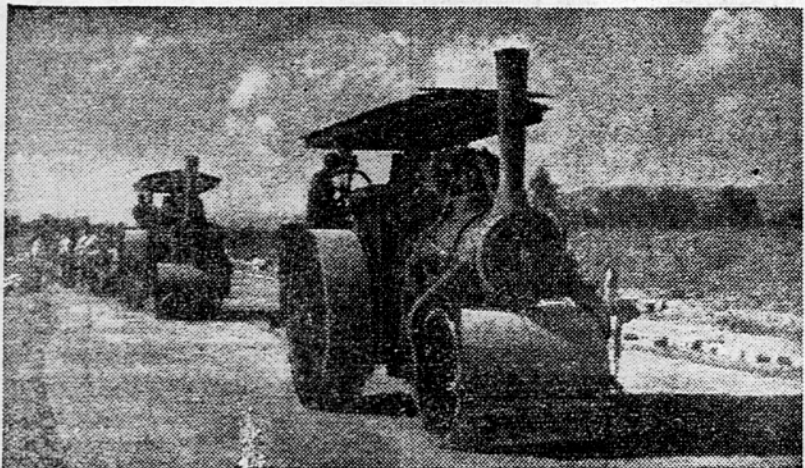
Valjanje asfaltnega cestišča na zadnjih kilometrih še nedograjenega avtomobilške ceste pri Novi Kapeli
