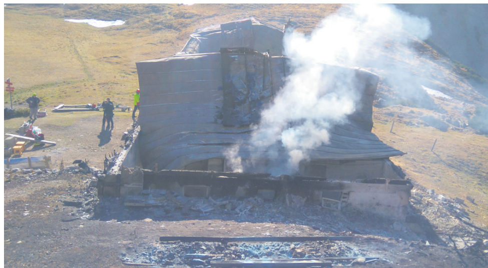
Tako je izgledal Kocbekov planinski dom na Korošici po usodnem požaru.
