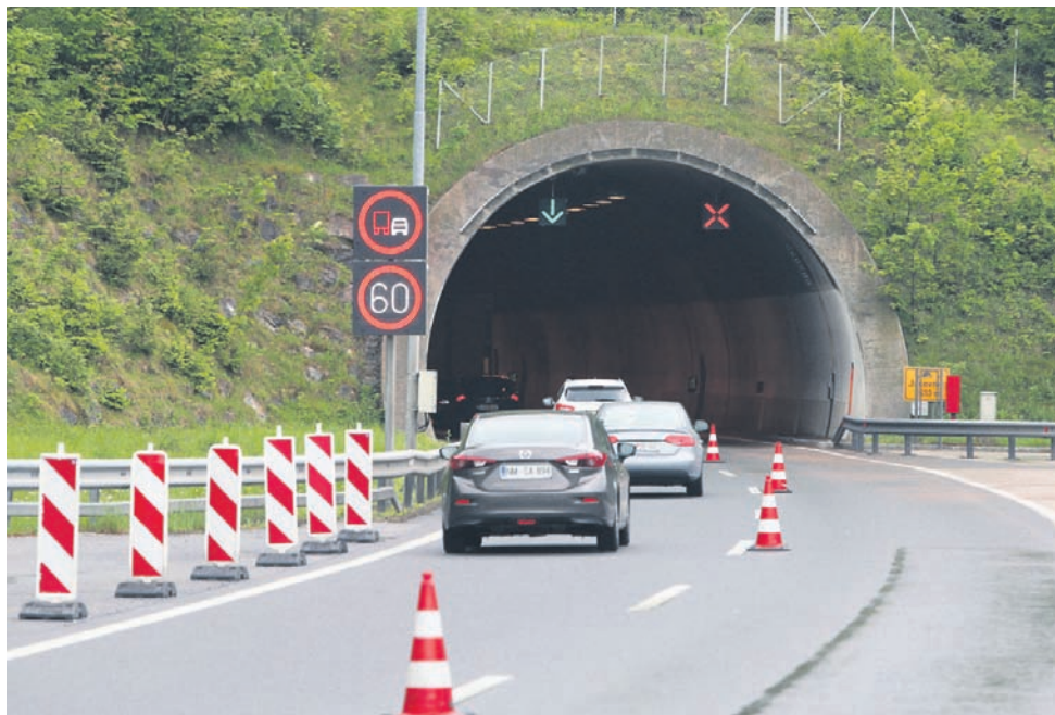
V času obnove avtocestnih tunelov je promet na državni cesti med Šentrupertom in Ločico izjemno gost.
