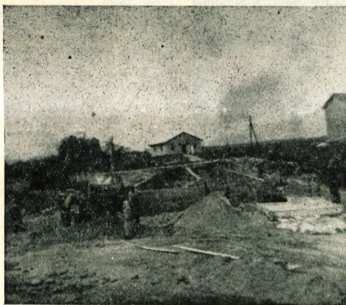
Graditev stanovanjskega bloka na Zlatem polju
