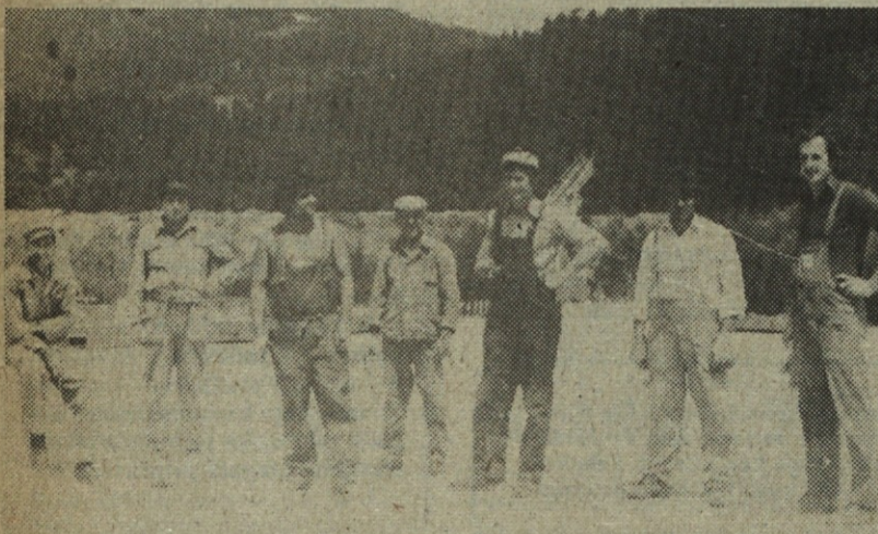
delavci, tesarji in zidarji. Temelji so rasuti in našega dela ni več videti
