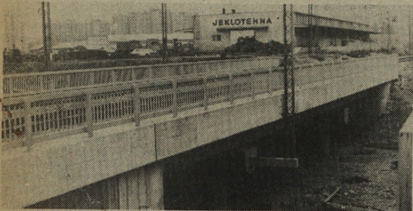
Železniški nadvoz nad Ptujsko cesto v Mariboru
