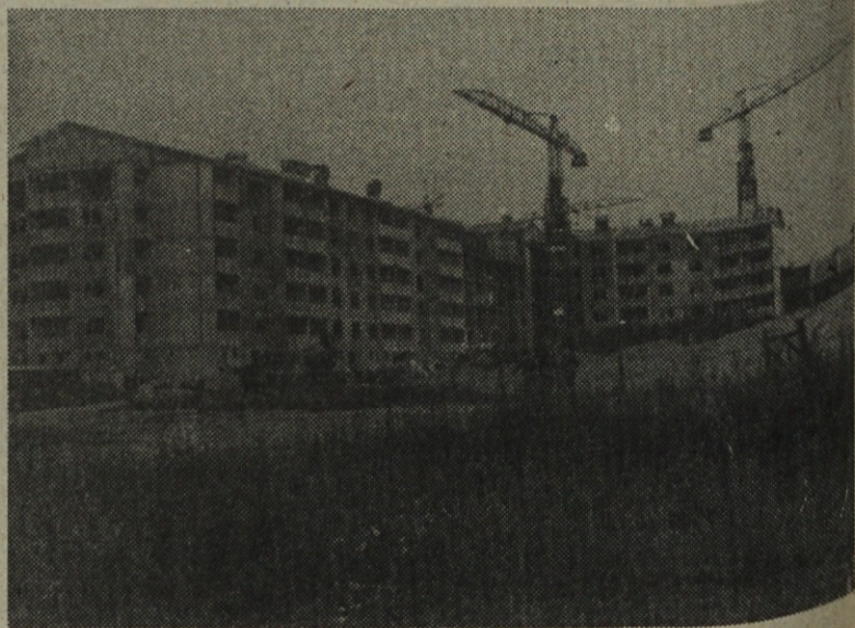
Gradnje Ptuj so več kot 50% angažirane na stanovanjski gradnji
