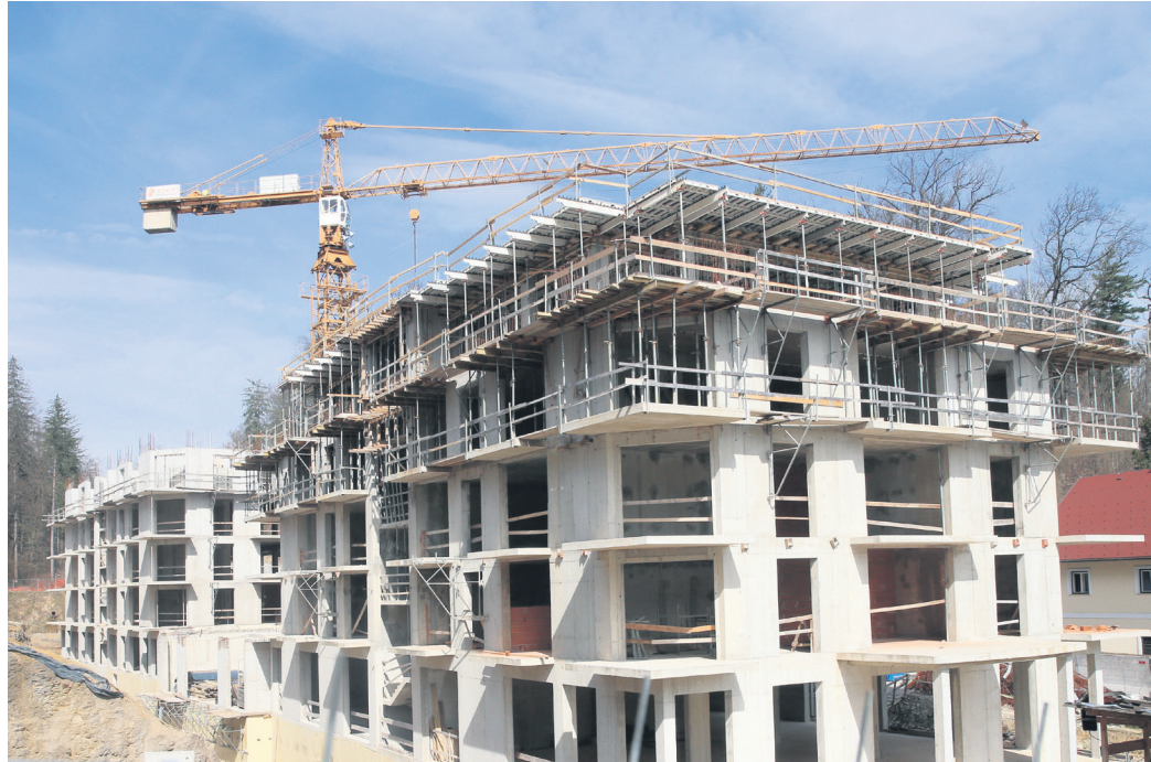
Gradbišče apartmajskega hotela Golden Pegasus
