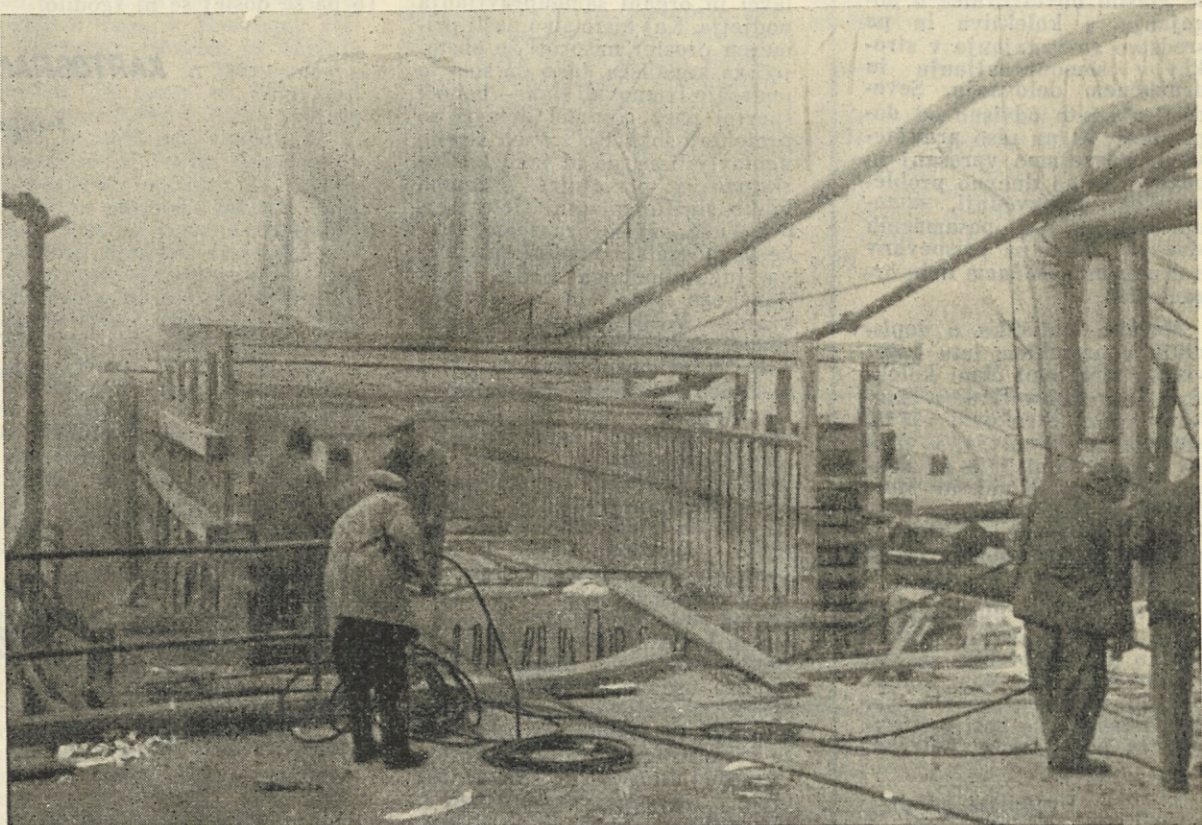
Posnetek z dne 25. 2.: opaži in armiranje novega mostu je že pri koncu... Letos spomladi bomo že hodili — in se lahko tudi vozili — po novem mostu!
