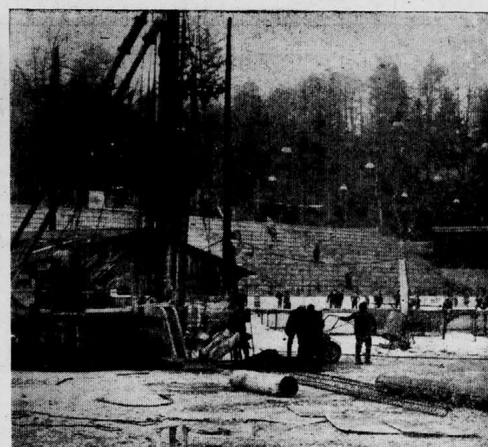
PRVI TEMELJI ZA NOSILCE NOVE STREHE — Tribune ob drsališču v športnem parku Stanka Bloudka so prepeleli drugam, da so mogli delavci beograjskega podjetja Jugofund začeti z delom. V globino 12 metrov so vgradili železobetonske pilote, ki bodo nosili streho športne dvorane, v kateri bo leta 1965 svetovno prvenstvo v namiznem tenisu.
