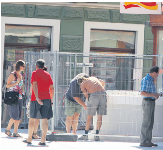
Med obnovo odkrit vodnjak čaka še na zaščitno kovinsko rešetko. V njem bo namreč zaradi zaščite lesenega temeljnega oboda ves čas voda.
