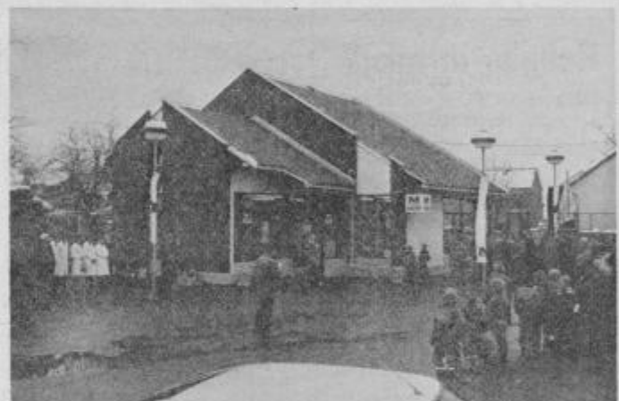
Leta 1985 je Zarja zgradila novo trgovino v Knežincu
