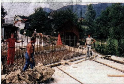
Gradnja mostu čez potok Trebnik v Braslovčah
